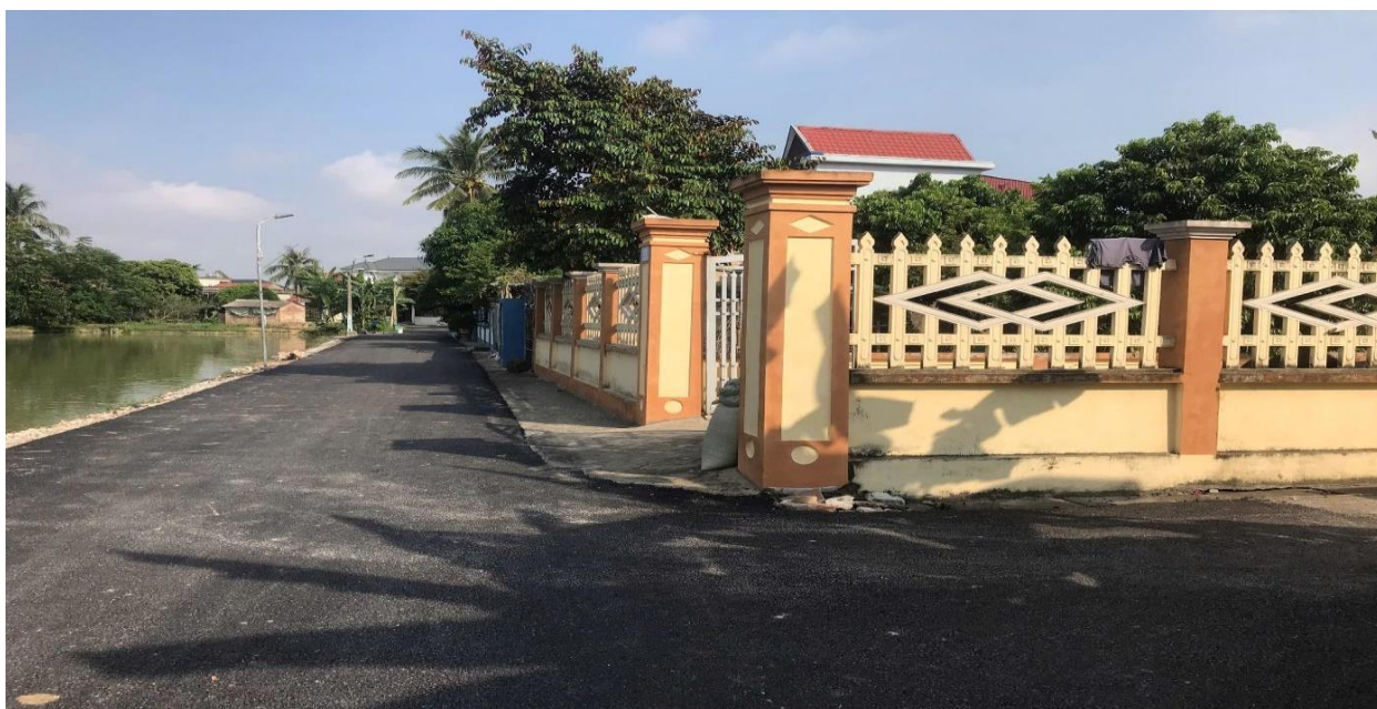
Đường giao thông nông được thảm nhựa của thôn Thôn Dân Tiến
