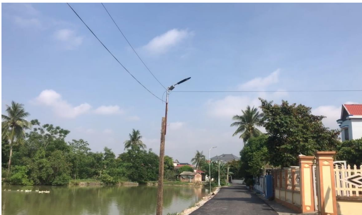
Đường thảm nhựa kết hợp đường điện chiếu sáng
